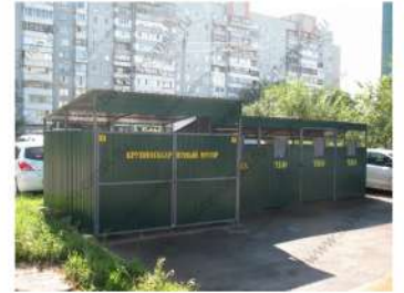
площадка для размещения контейнеров крупногабаритного мусора
